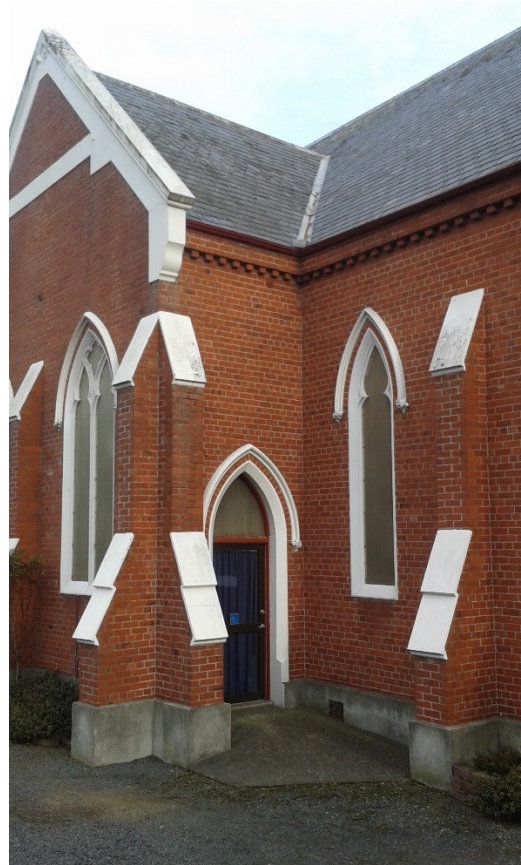
Transept egress door
